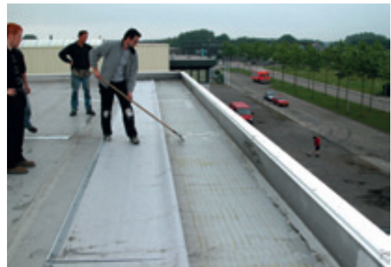
Fig. 2: De lijm moet met een rubberen trekker of spatel gelijkmatig verdeeld worden.
