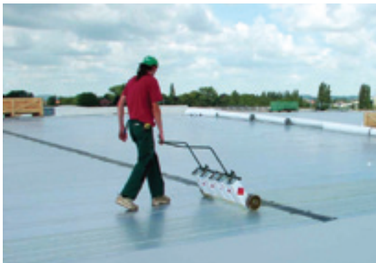
Fig. 1: Aanbrengen van lijm met de rolwagen
