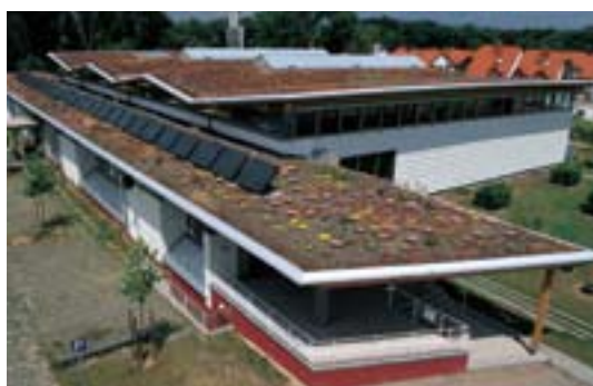
1 Centre Sportif (Allemagne)
