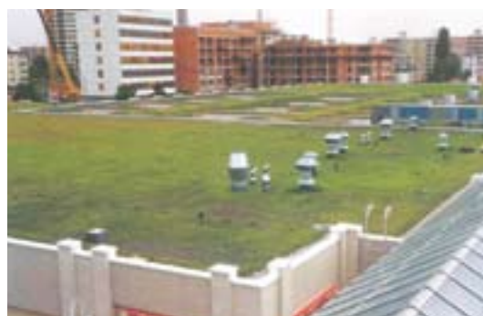
2 Centre commercial (Allemagne)
