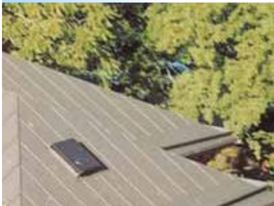
Progetto: Alkor Design - Ristrutturazione e impermeabilizzazione di una copertura metallica. Via: Via S. Vito, 10 - 00144 Roma (RM) Telefono: +39 06 47811111 - Fax: +39 06 47811112
