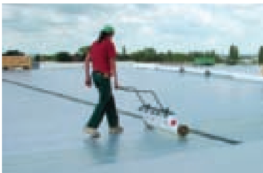
Bilde. 1 bruk av utleggsmaskin.
