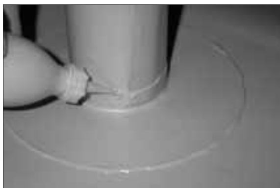
Fig. 3: ALKORPLAN® 81038 vloeibare folie aangebracht met het ALKORPLUS 81145 spuitflesje
